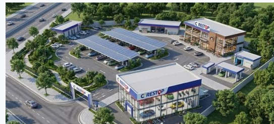
Toàn cảnh trạm
